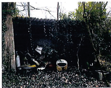
A droite, un édifice composé d'une structure en bois surmonté par de la tôle ondulée. Au sol, de la terre battue. Au fond et à gauche, un mur de parpaings jointoyés à l'état brut.
