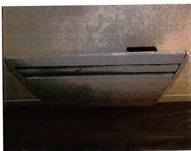
Fixé sur le mur de droite, un convecteur électrique de marque AIRELEC.
